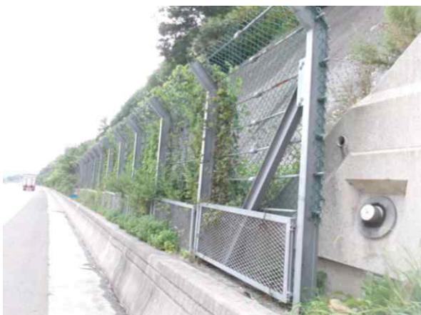
도로, 낙석방지울타리 전경
