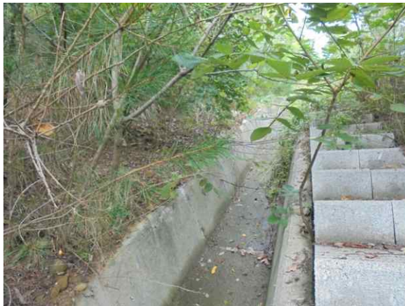
산마루측구, 점검계단 전경
