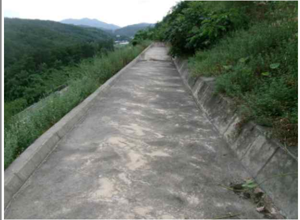
1소단 배수로 전경
