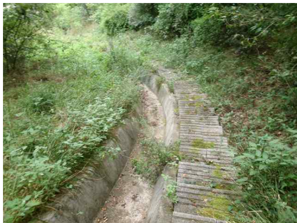
점검계단 및 산마루측구 전경
