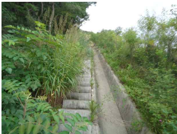
산마루측구, 점검계단 전경
