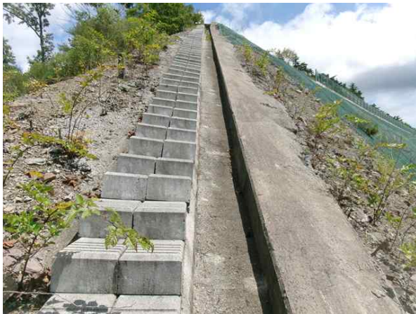
산마루측구, 점검계단 전경
