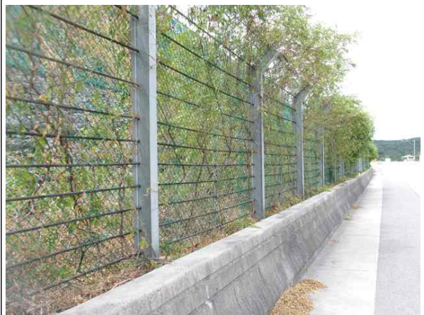
도로, 낙석방지울타리 전경
