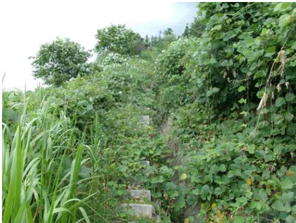
산마루측구, 점검계단 전경
