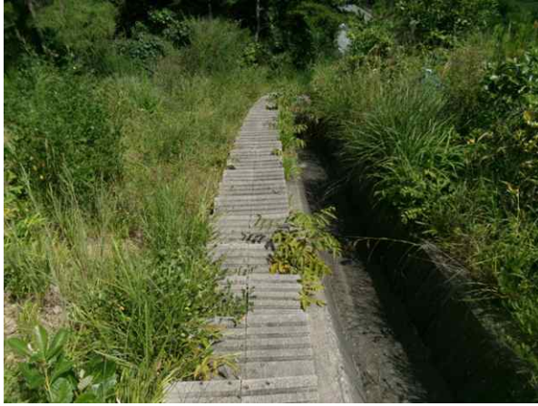
산마루측구, 점검계단 전경
