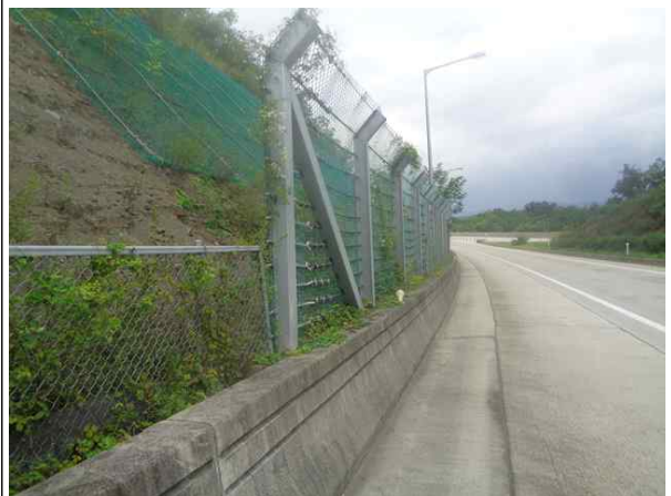
하부 낙석방지울타리 전경
