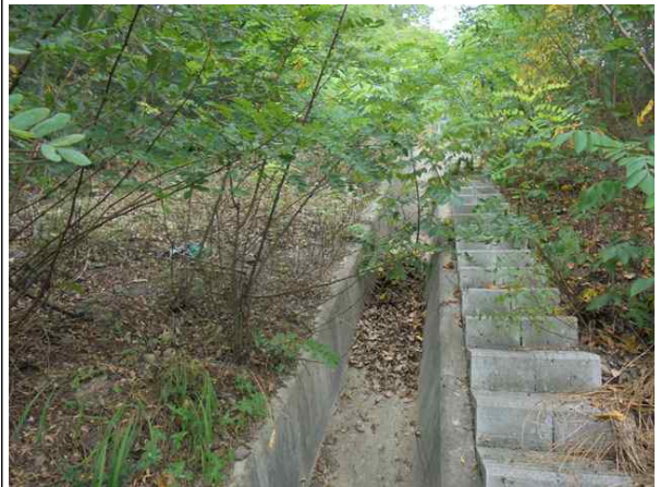
산마루측구, 점검계단 전경
