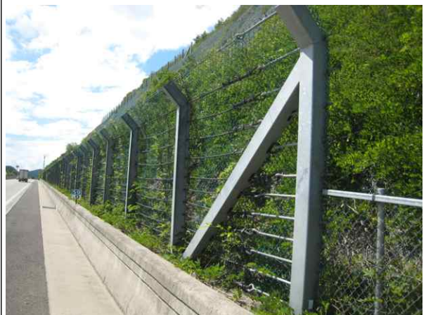
도로, 낙석방지울타리 전경
