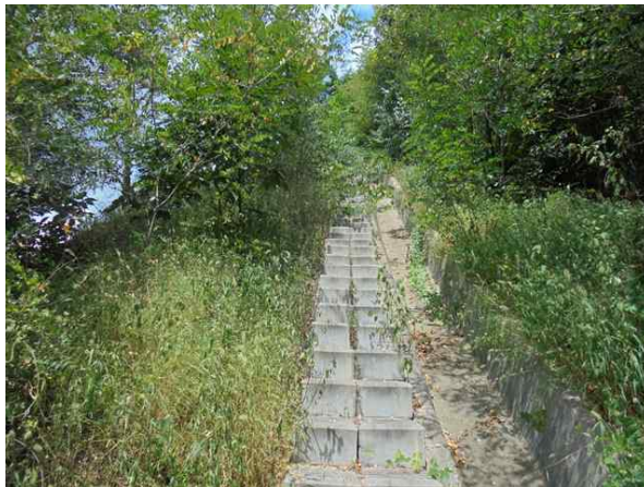
산마루측구, 점검계단 전경
