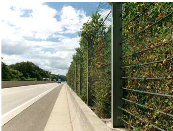
도로, 낙석방지울타리 전경
