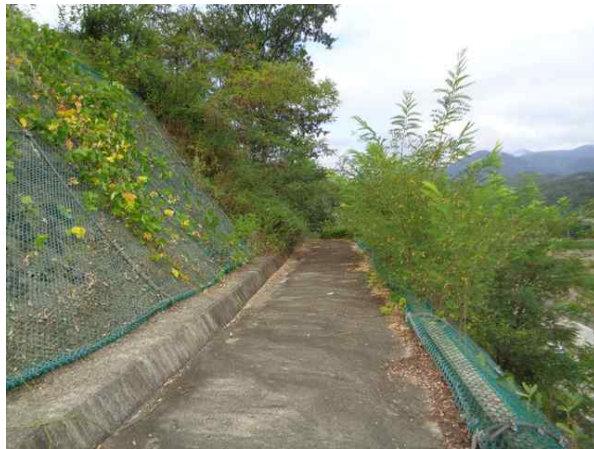
1소단 배수로 전경
