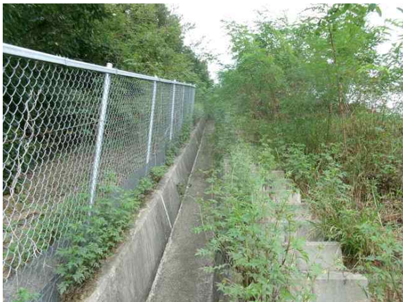
산마루측구, 점점계단 전경
