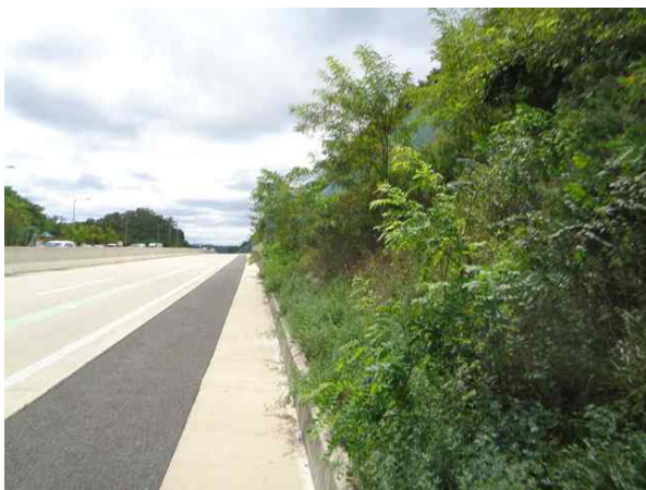
도로, 낙석방지울타리 전경
