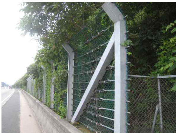
도로, 낙석방지울타리 전경
