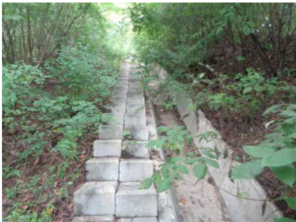
산마루측구, 점점계단 전경
