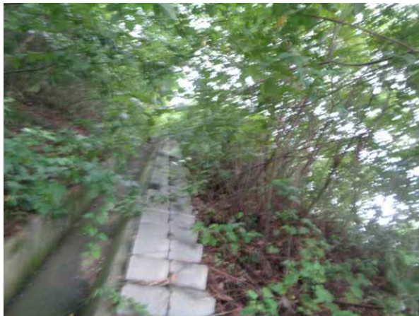
산마루측구, 점점계단 전경
