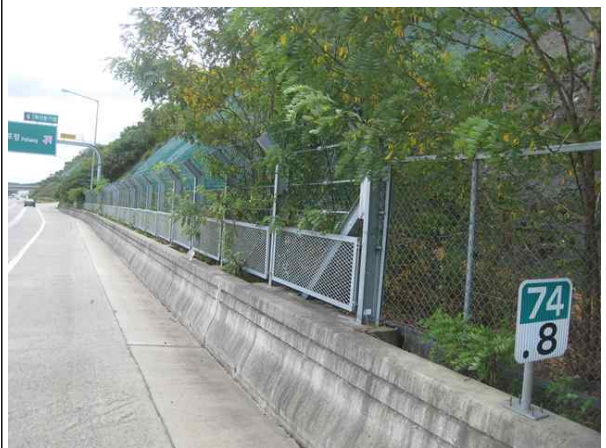
도로, 낙석방지울타리 전경
