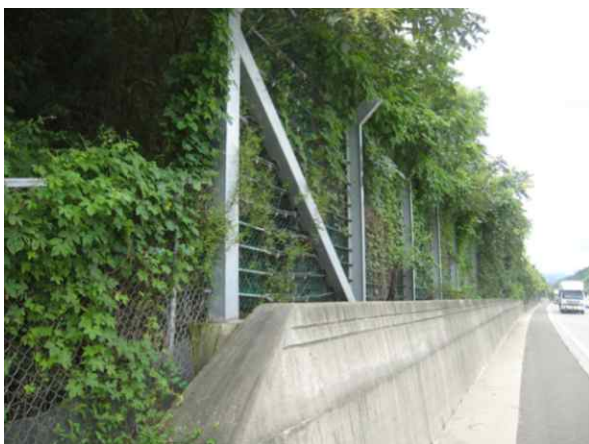
도로, 낙석방지울타리 전경
