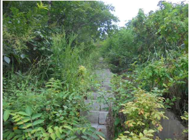
점검계단, 산마루측구 전경
