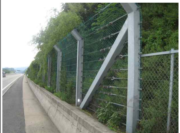
도로, 낙석방지울타리 전경
