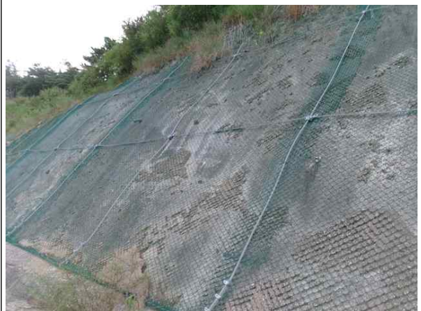
쑈크리트, 점검계단 전경
