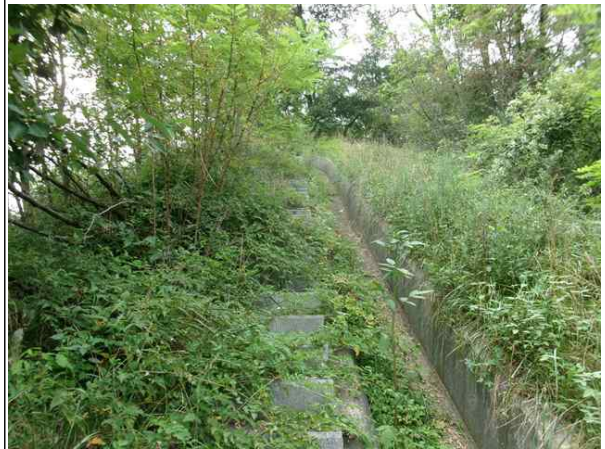
점점계단, 산마루측구 전경
