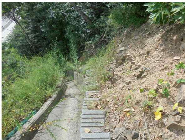
산마루측구, 점검계단 전경
