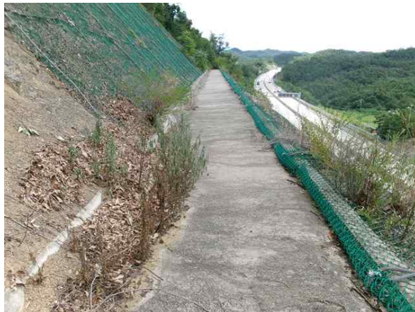
1소단 배수로 전경
