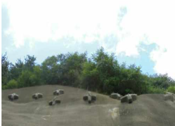
슛크리트, 격자블럭 전경
