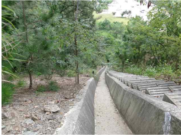
산마루측구, 점검계단 전경
