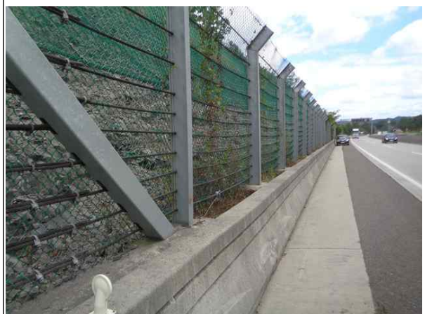
도로부 및 낙석방지울타리 전경
