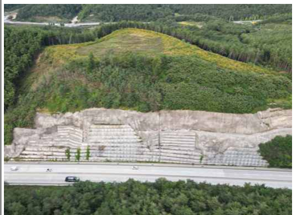
사면내 옹벽 전경
