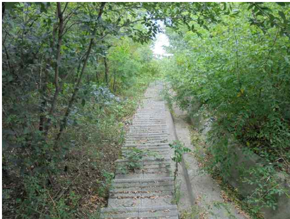
산마루측구, 점점계단 전경
