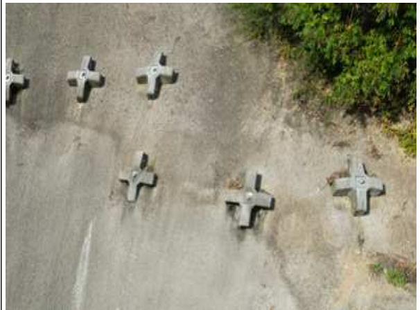
슛크리트, 격자블럭 전경
