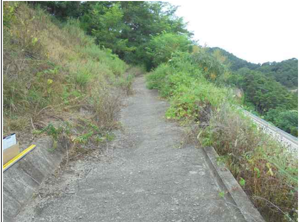
1소단 배수로 전경
