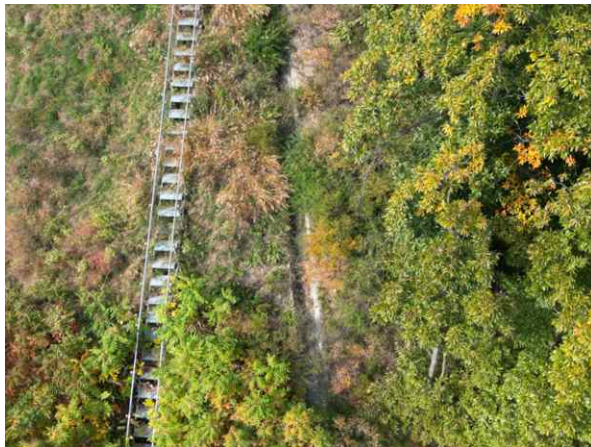
산마루측구, 점검계단 전경
