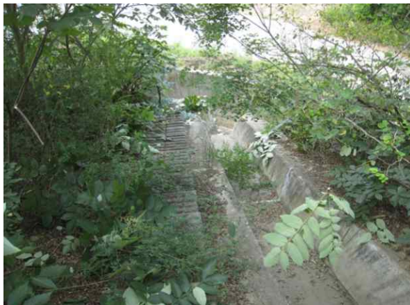
산마루측구, 점검계단 전경
