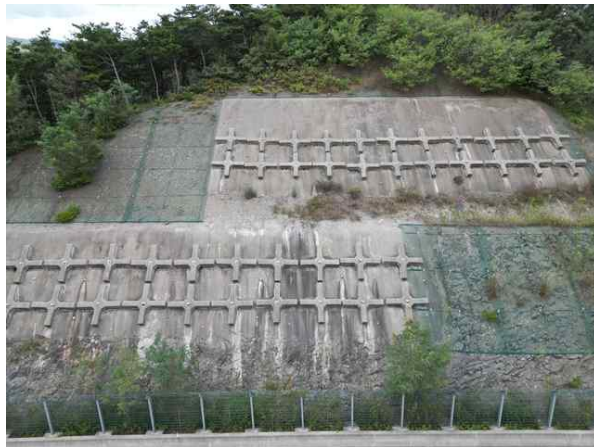
슛크리트, 격자블럭 전경
